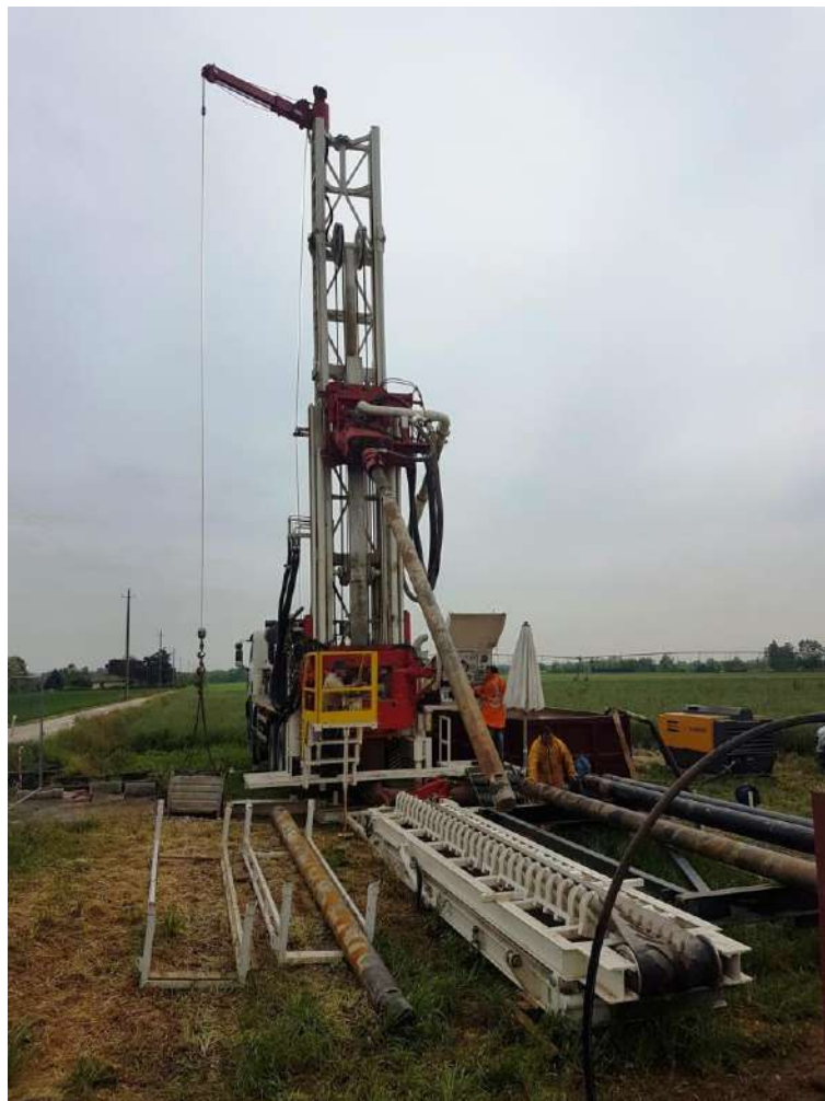
Perforazione a roto-percussione ad aria, rotazione con circolazione diretta ed inversa
