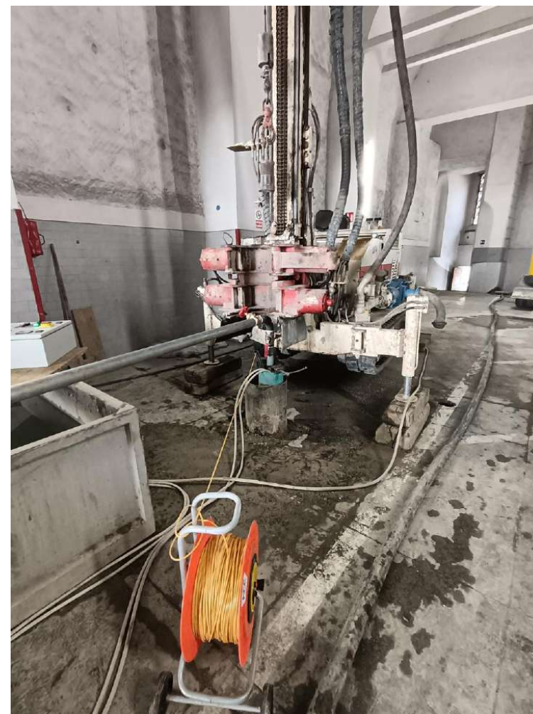
Perforazione a roto-percussione ad aria, rotazione con circolazione diretta ed inversa
