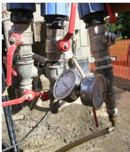
**anche dopo la cementazione, al fine di verificare subito se tutte le operazioni di installazione almeno non abbiano «rotto» la sonda geotermica**
