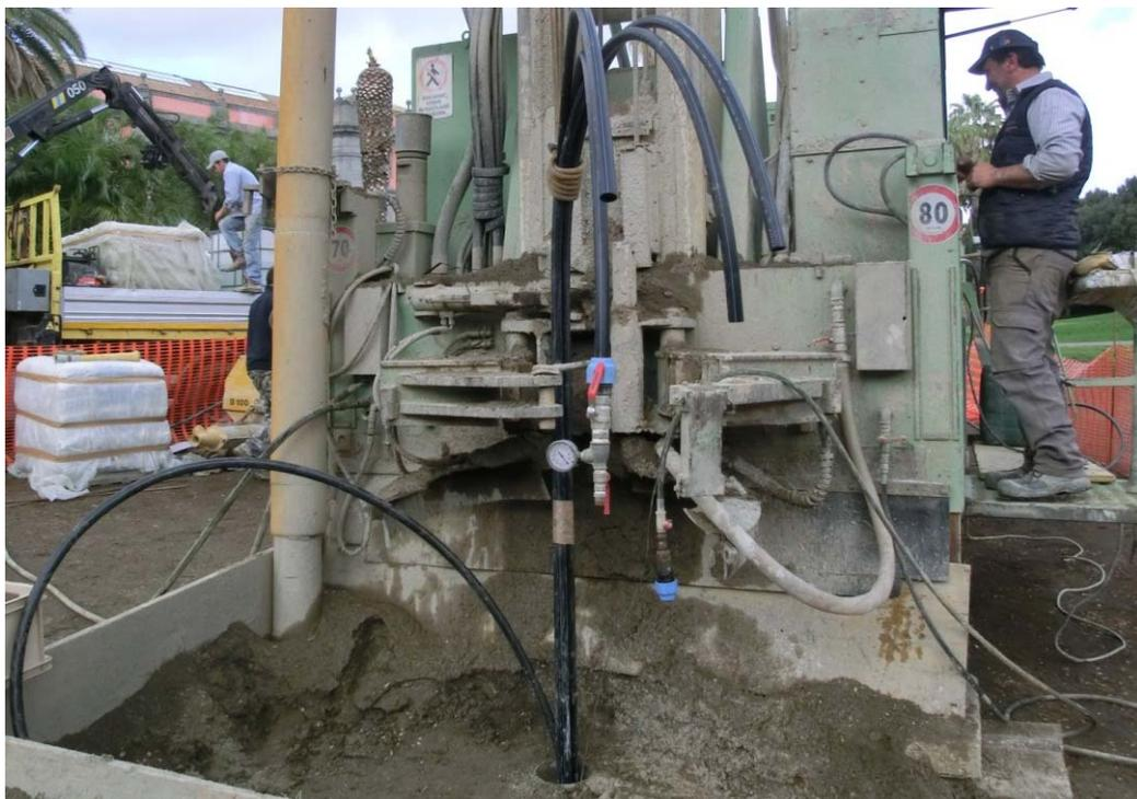
**LA CEMENTAZIONE DELLA SONDA GEOTERMICA È, DI NORMA (UNI), «OBBLIGATORIA» .....**
