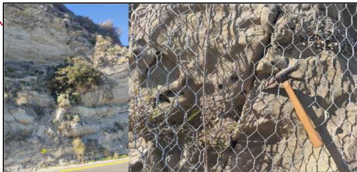
Imbocco Sud Galleria Bruzzano (RC)
