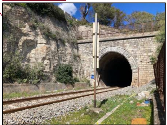
Imbocco Sud Galleria Zeffiro (RC)
