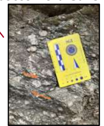
Imbocco Nord Galleria Staletti (CZ)
