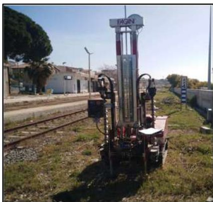
Rilevato ferroviario Stazione di Palizzi
