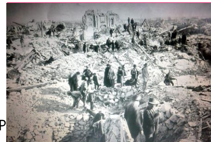
Terremoto del Fucino
