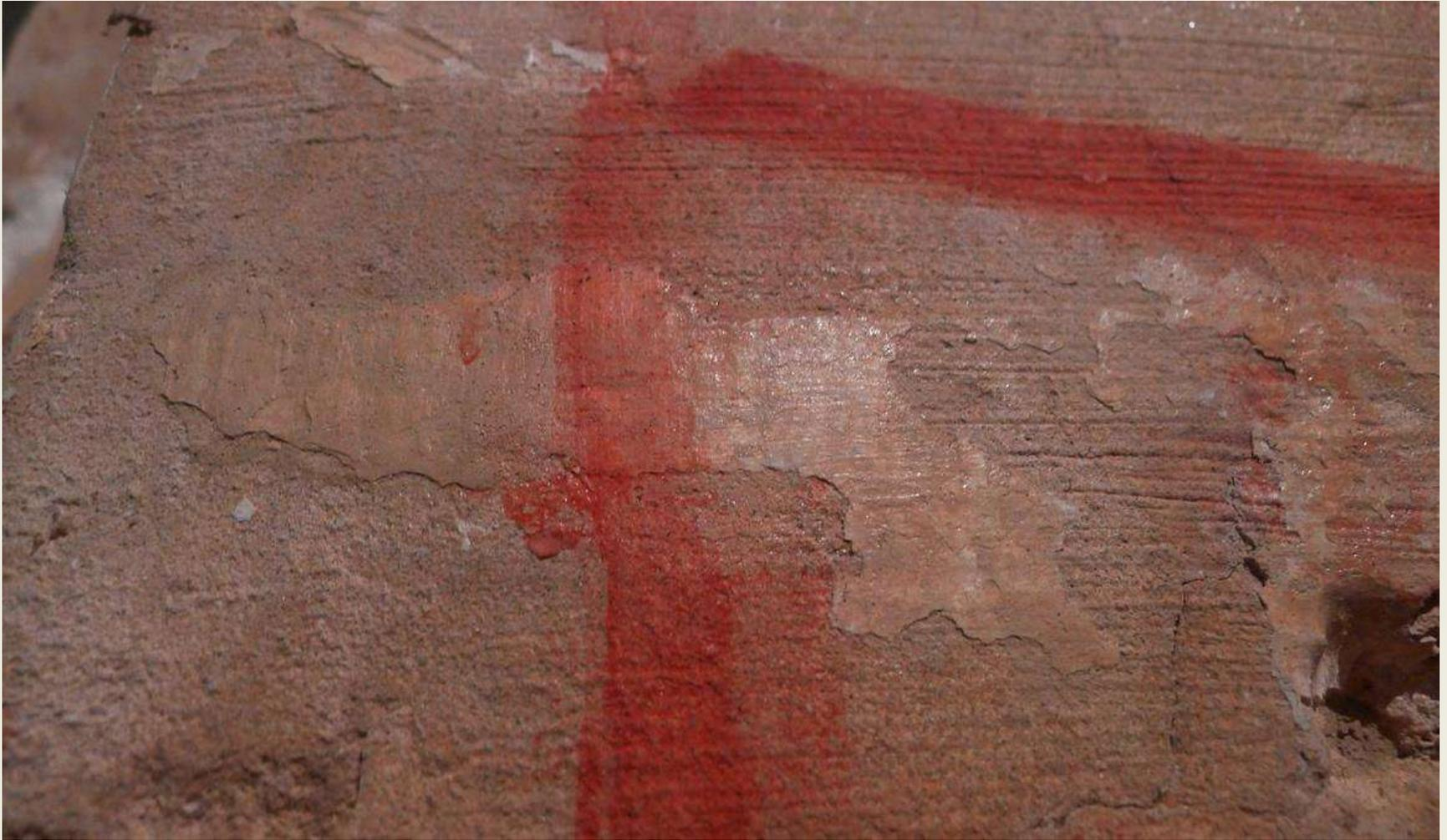
**Particolare di un pilastro con intonaco di rifinitura e “Graffiti” di colore rosso, in cui è stata rimossa solo in parte la calce di copertura dei militari italiani: sono evidenti i solchi della rimozione meccanica a mano lasciati sia sull’intonaco e sui “Graffiti”. E’ stata operata una “ripresa” del colore rosso dei “Graffiti” anche come raccordo di integrazione a coprire la malta dei militari.**
