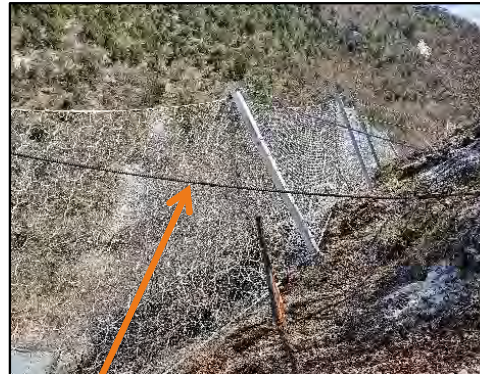
Componenti di connessione (funi, morsetti, grilli...)
