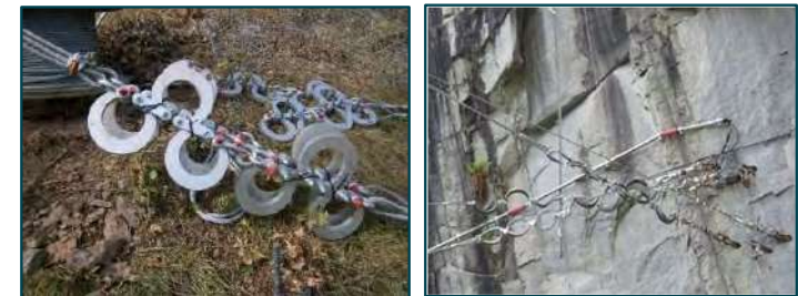
Dissipatori di energia
