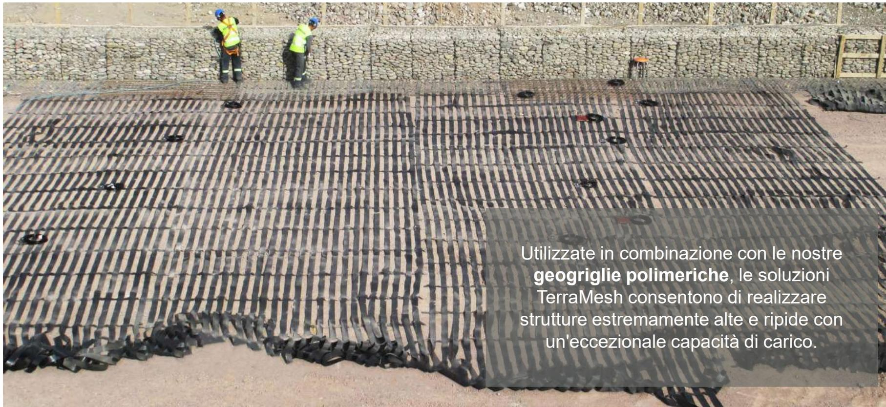
Utilizzate in combinazione con le nostre **geogriglie polimeriche**, le soluzioni TerraMesh consentono di realizzare strutture estremamente alte e ripide con un'eccezionale capacità di carico.
