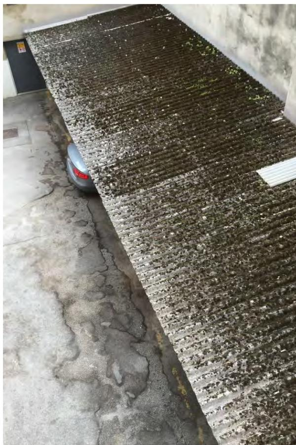
Figura 5: tettoia in cemento amianto (foto S. Massera)
