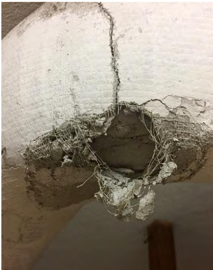
Figura 4: tubazione danneggiata con rivestimento in amianto crisotilo a vista (foto S. Massera)
