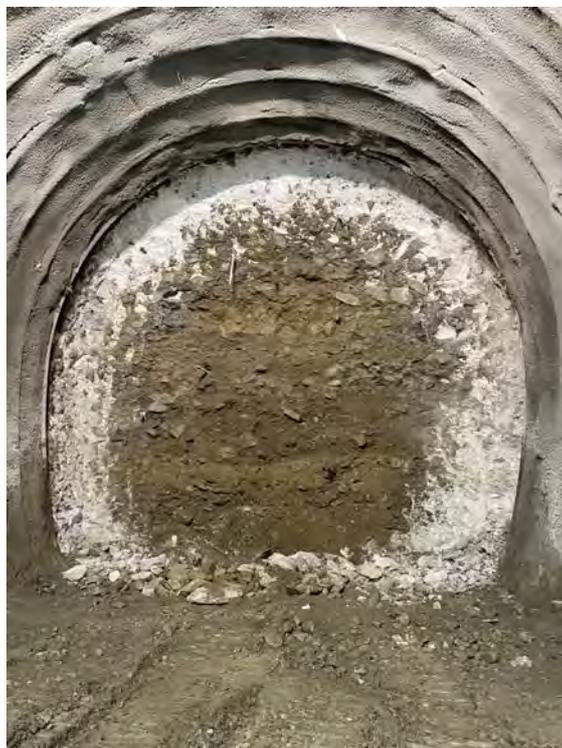
Fig. 23 Fase di scavo e particolare della fascia di terreno congelato visibile all'interno del profilo di scavo
