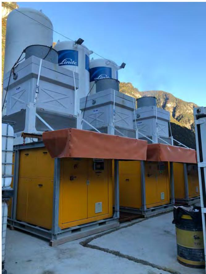
*Fig. 16 Impianto frigorifero di stoccaggio dell'azoto liquido*
