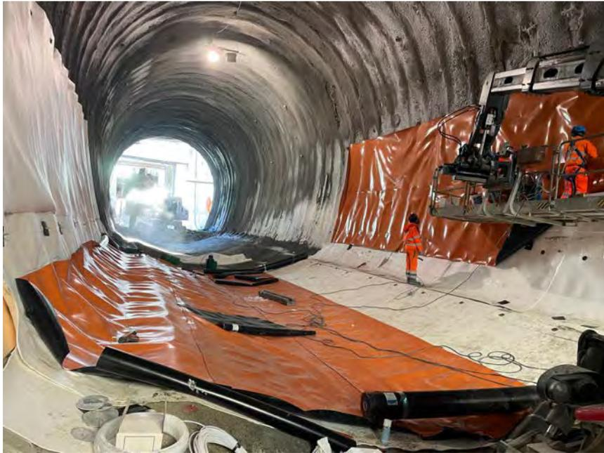
*Fig. 24 Fase di impermeabilizzazione dell'arco rovescio*
