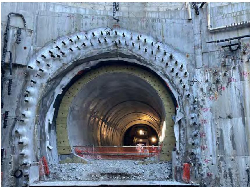
*Fig. 25 Fase di posa dell'armatura e getto per il completamento della galleria*
