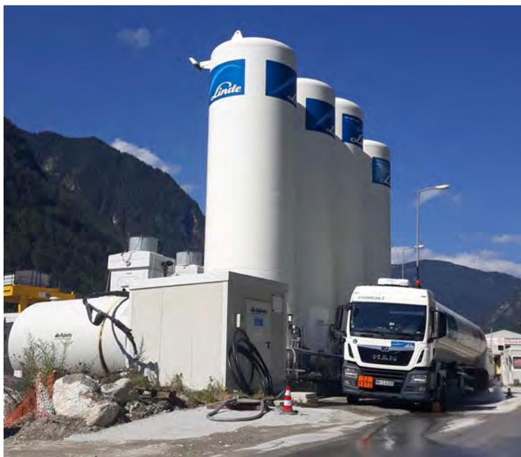
Fig. 14 Impianto frigorifero di stoccaggio dell'azoto liquido
