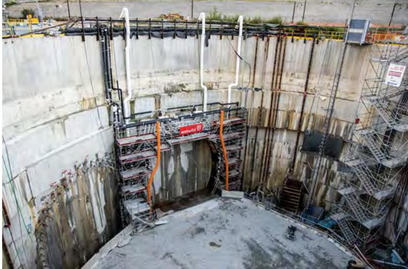
*Fig. 15 Vista della GN-IPI da Pozzo PO-BPN durante il congelamento ad azoto*
