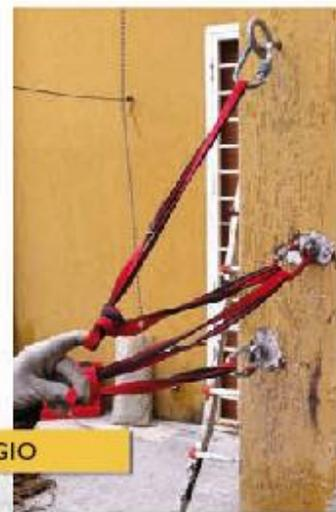
INSERIMENTO RESINE E REALIZZAZIONE DEL SISTEMA DI ANCORAGGIO
