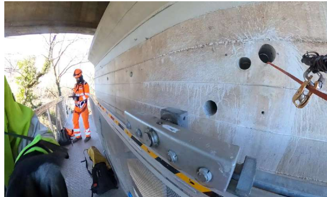
Accesso alla pila dal by bridge
