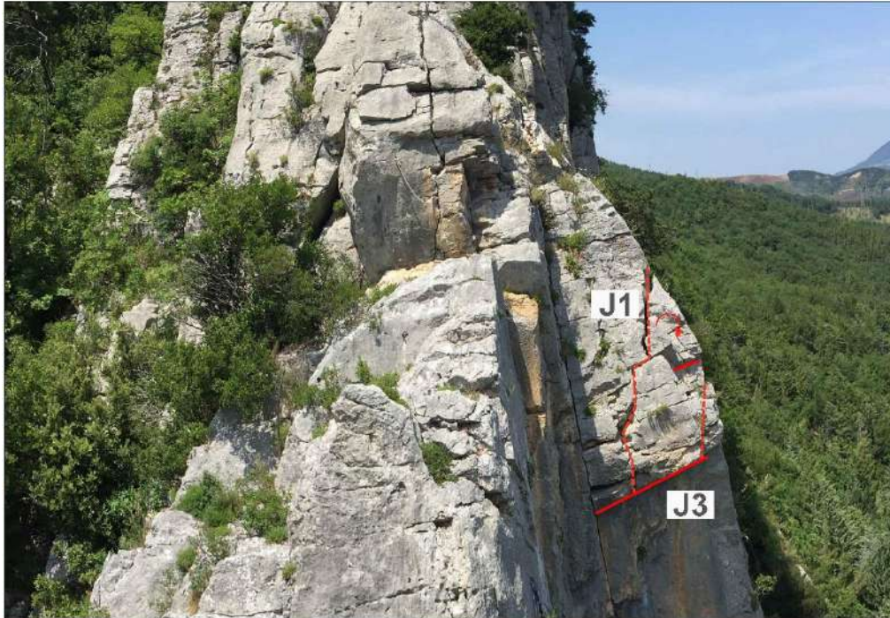
Particolare di un blocco individuato dalle discontinuità J1 e J3 soggetto al ribaltamento
