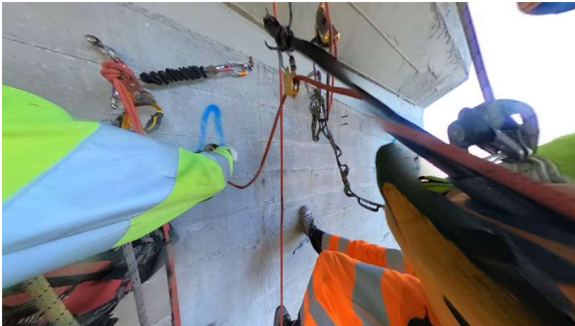
Accesso con calata diretta su fune , posizionamento e ancoraggio con tecniche alpinistiche
