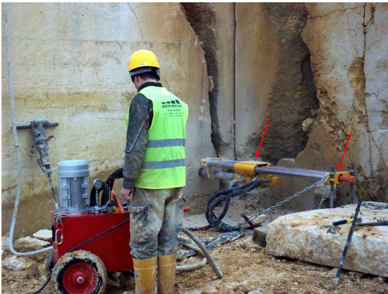
Perforatore idraulico servito da centralina elettrica
