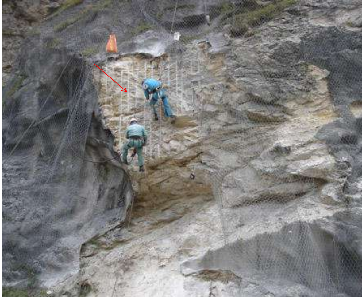
Operazioni di Disgaggio
