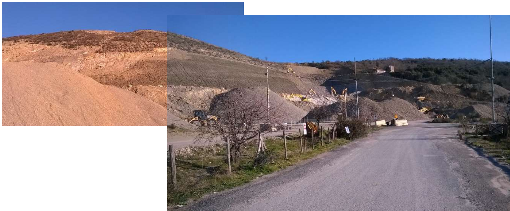
Cava Fiorotta CV-Rm completamente interessata dalle lavorazioni
