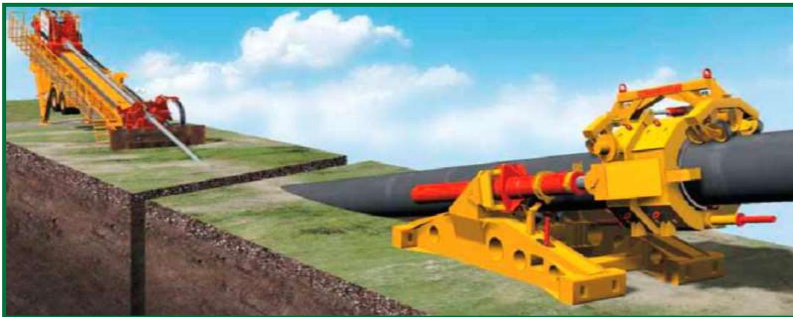
Soluzione intermedia tra la TOC e la direct pipe. Ovvero, effettuare tutte le attività di perforazione con la metodologia TOC (foro pilota e tutti gli alesaggi), mentre la fase finale di tiro-posa della condotta sarebbe stata coadiuvata ed assistita dal Pipe Thruster del Direct Pipe.
