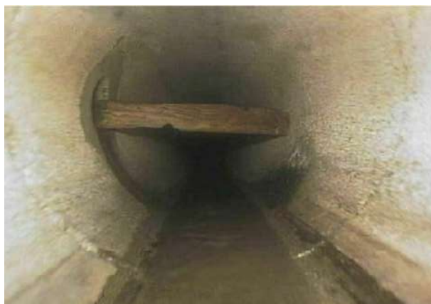
Condotto che attraversa il canale
