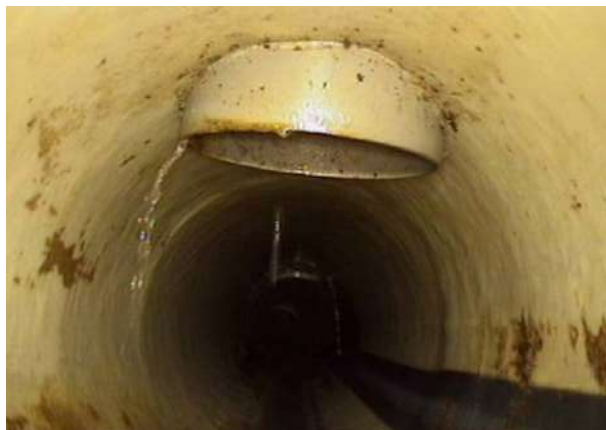
Connessione sporgente
