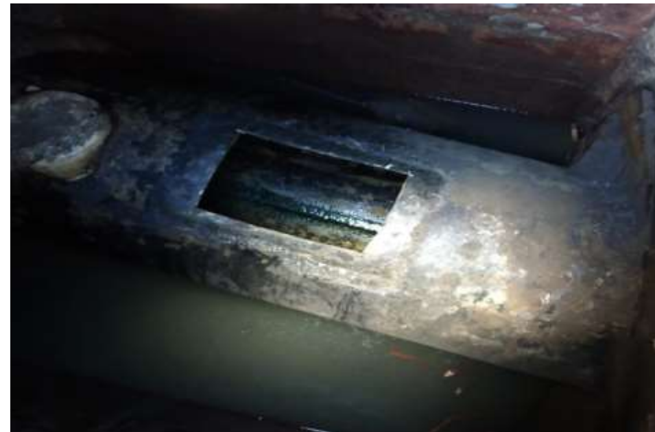
Finestra di ispezione realizzata in urgenza sul pozzetto in alveo
