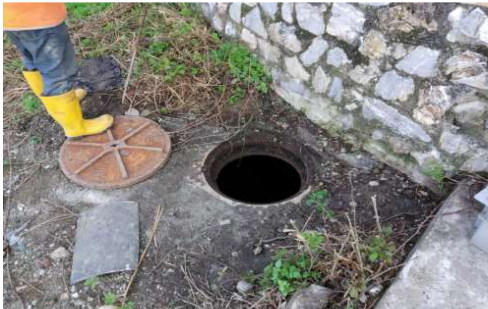
Pozzetto esistente all'ingresso nell'alveo (lato fiume), in foto il muro arginale esistente lato fiume
