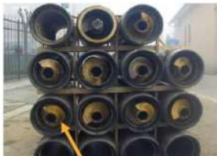
Tubazioni stoccate nell'area cantiere con coclea innestata pronta per la spinta
