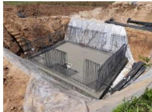
Fig.13 Realizzazione in opera pozzo in c.a.
