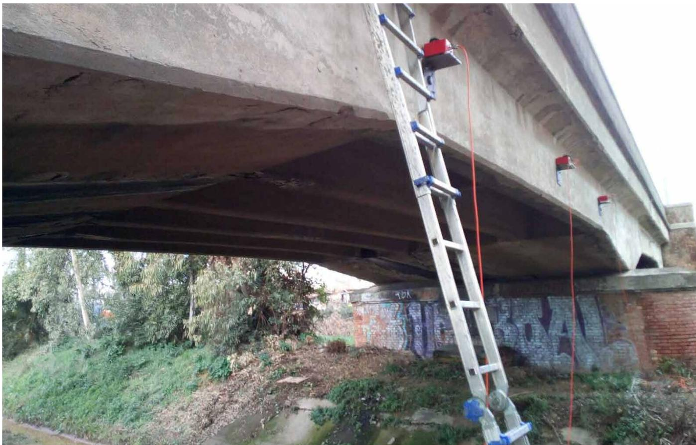
Fig. 6 - Disposizione dei sensori per misure dinamiche su impalcato.
