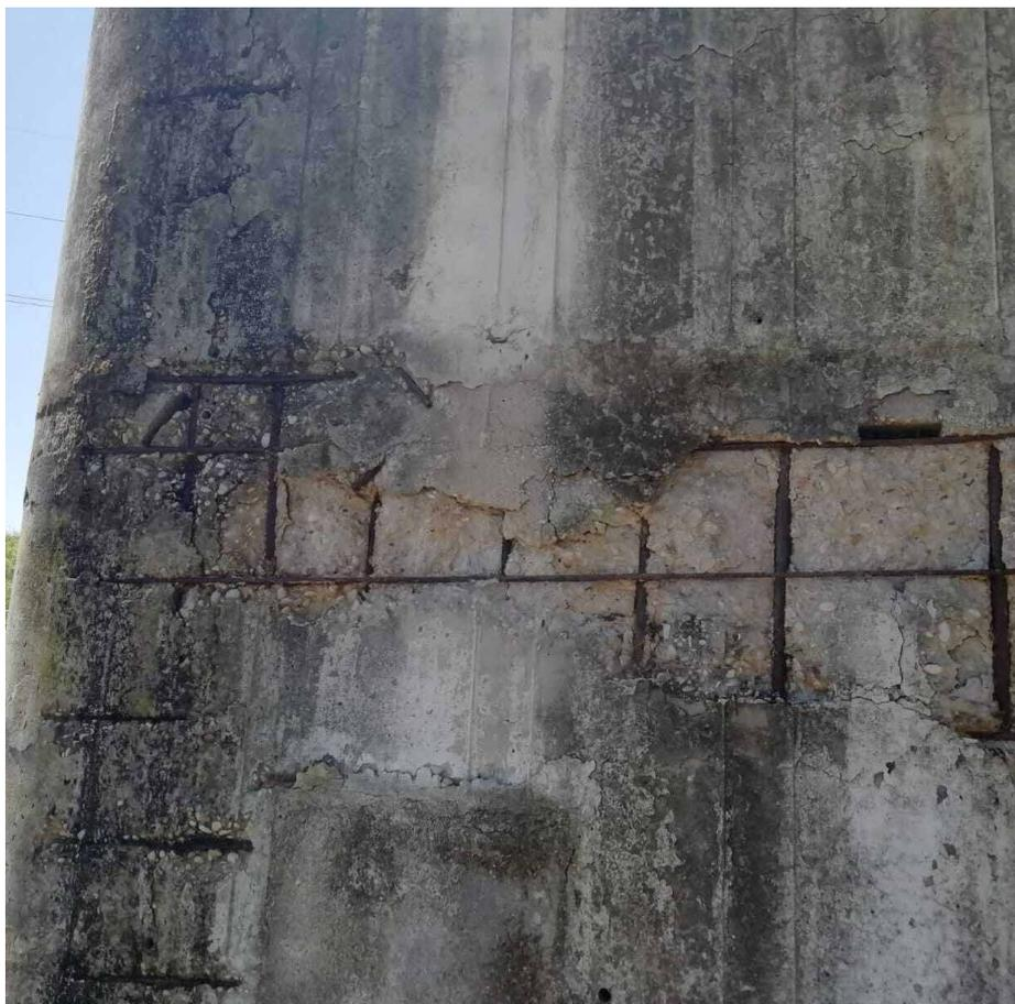
Fig. 1 - Esempio di espulsione del copriferro in seguito a carbonatazione e corrosione dell'armatura.
