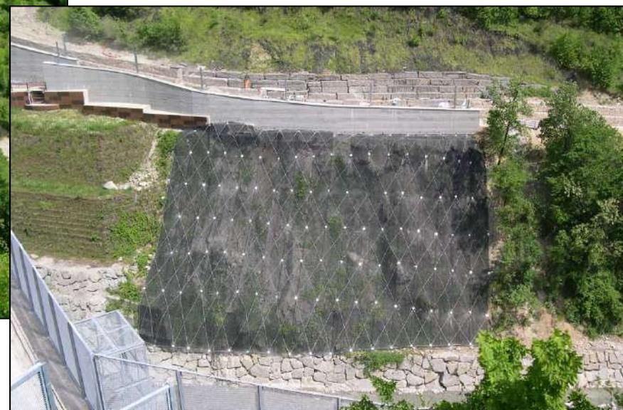
Rivestimento anti-erosivo e consolidamento di pendii in terreno sciolto o con copertura detritica
