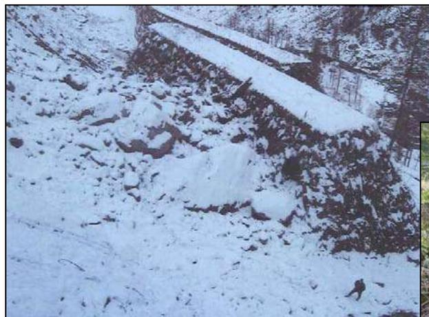
Uno dei rilevati paramassi di Cogne dal 2007 al 2011 è stato impattato da piccole valanghe, colate detritiche e da massi
