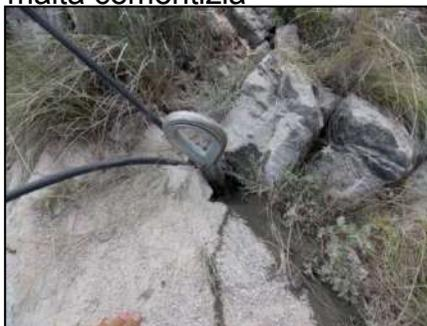
Alloggio barre di fondazione del montante e iniezioni di malta cementizia
