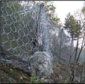
Struttura di supporto (montanti)
