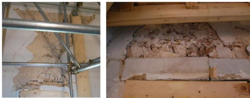
*Danneggiamento delle fasce di piano al di sopra del vano porta*
