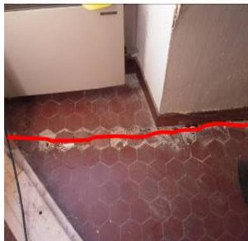
*Lesione dell'orizzontamento con distacco della pavimentazione*
