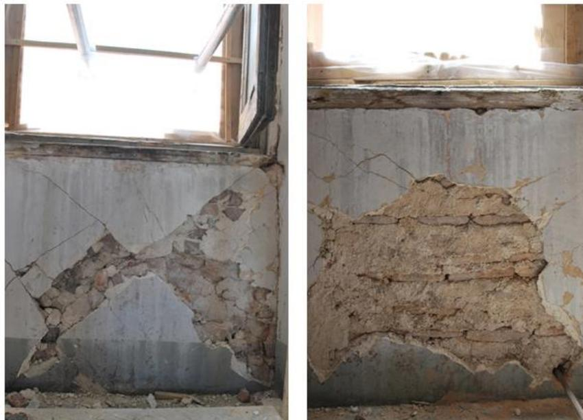
*Danneggiamento delle fasce di piano al di sotto del vano finestra*
