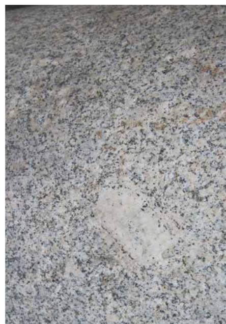
Fig. 9 - Colonna in Gr. Elbano caratterizzata da grandi megacristallichiaridi K-feldspato (il lato corto della foto misura circa 50cm).
