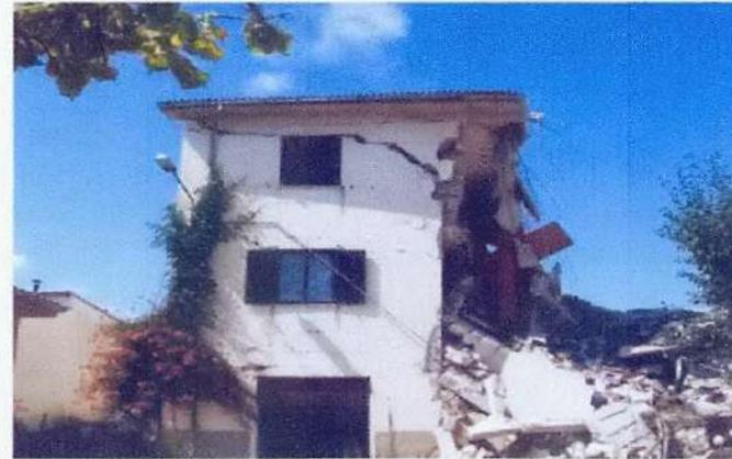
Stato Limite di prevenzione del Collasso (Near Collapse) (Onna)
