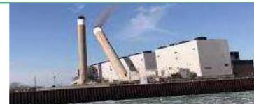
**-Lo stato limite per la perdita dell'equilibrio EQU** della struttura o di una sua parte considerati come corpi rigidi, **non riguarda più il terreno o l'insieme terreno-struttura, compreso adesso nelle verifiche GEO, ma tale verifica è limitata al ribaltamento di strutture fuori terra (ad esempio ciminiere, cartelloni pubblicitari, torri, ecc. rispetto ad una estremità della fondazione).**
