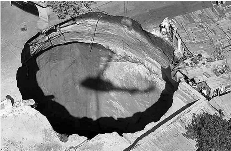
Immagine 1. Il sinkhole di Guatemala City del 24 febbraio 2007 (profondità circa 100m) che ha provocato la morte di 2 persone. (foto da www.ordena.com/digg/sinkhole.html )
