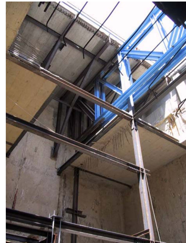
Puntoni in seconda fase (dopo il contrasto con le strutture di fondazione)
